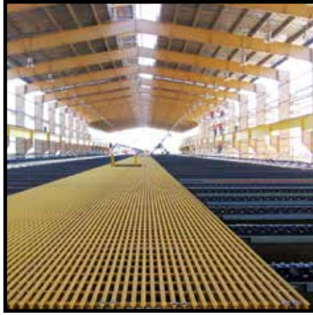
Instalación en mina de cobre
