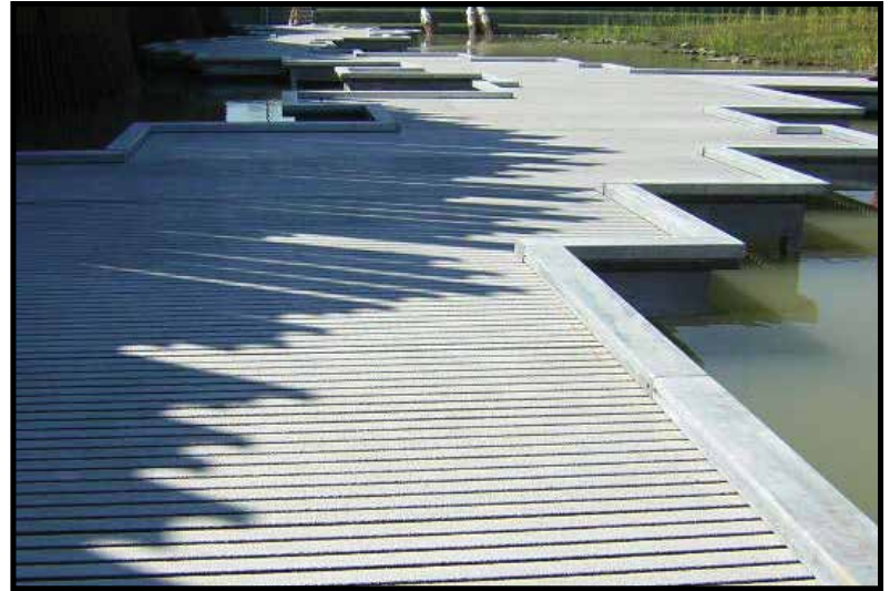
Muelle del pontón en Portland, Oregon.
